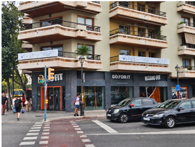
Fachada. Imagen con retoques de decoración.
